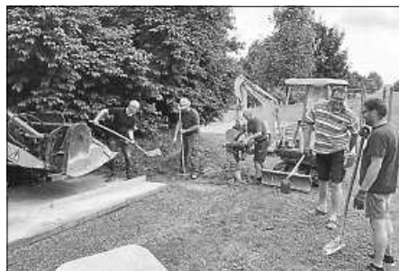
Erweiterung und Befestigung des Untergrunds für die neue Sitzckecke
