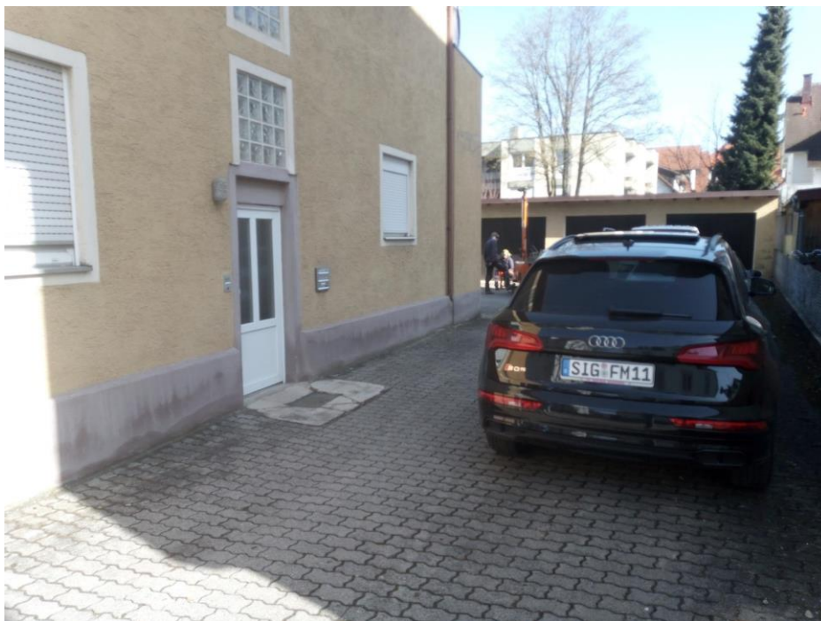
Bild 1: Bauareal am 25.02.21 (Einfahrt von der Kaiserstraße)
