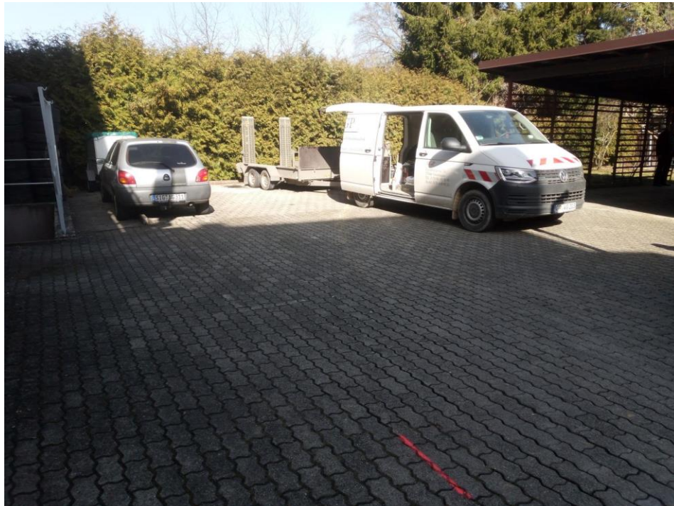
Bild 2: Bauareal am 25.02.21 (zentrale Hoffläche)
